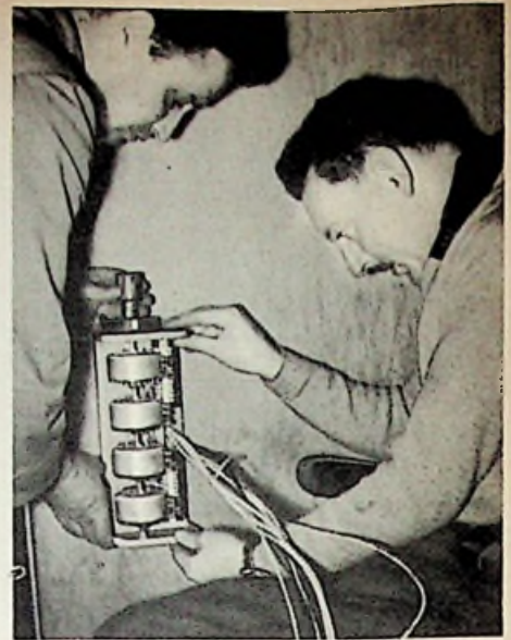
Bild 4. Montage eines Philips-Vierkanal-Saalreglers in einem Lichtspielhaus
